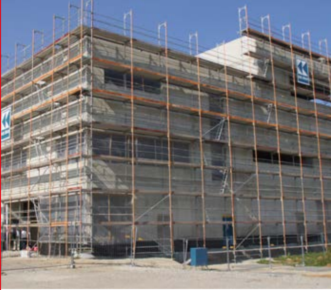
Das SportQuadrat im Rohbau.
